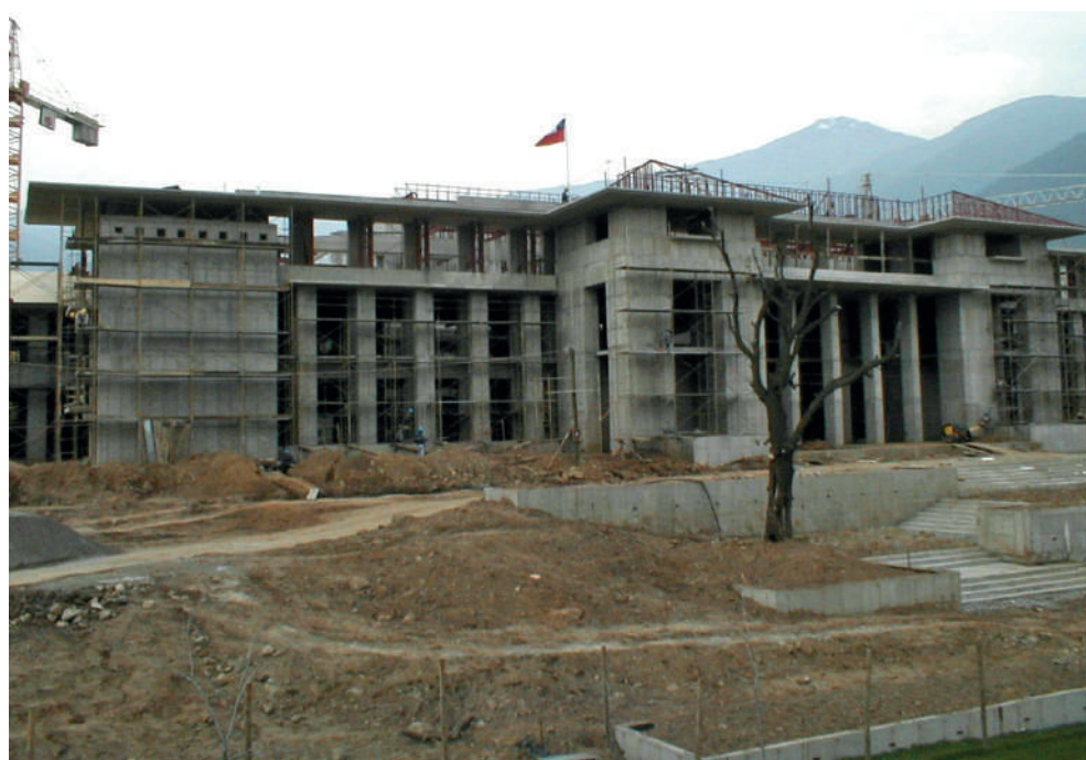
El edificio de Biblioteca en construcción, 2001.
