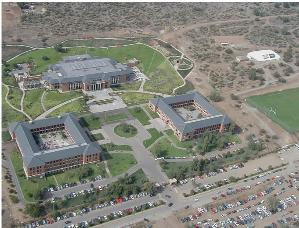
Los tres primeros edificios del campus universitario: Humanidades (a la derecha), Ciencias (a la izquierda) y Biblioteca (atrás).
